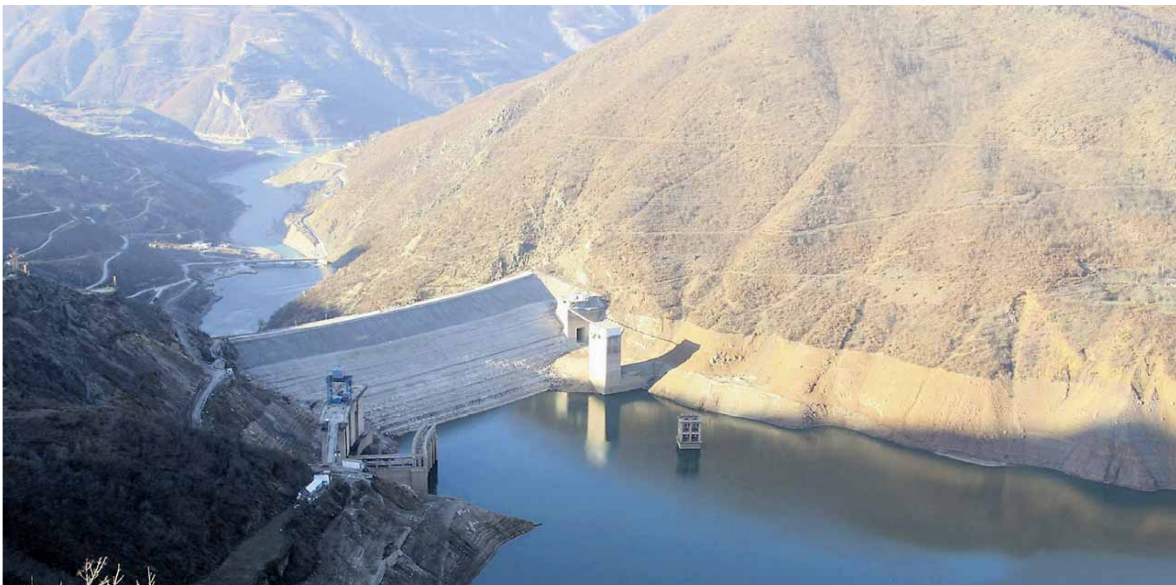
In Albanien erzeugen drei Wasserkraftwerke 98 Prozent des Stroms – eines davon ist der Fierza-Staudamm. Für die restlichen zwei Prozent sind 130 kleine Anlagen nötig.
